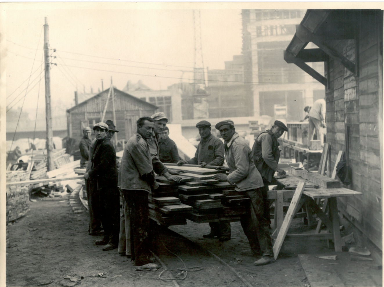
Menuisiers sur un chantier, années 1950. Photographie non identifiée – IHS CGT.
